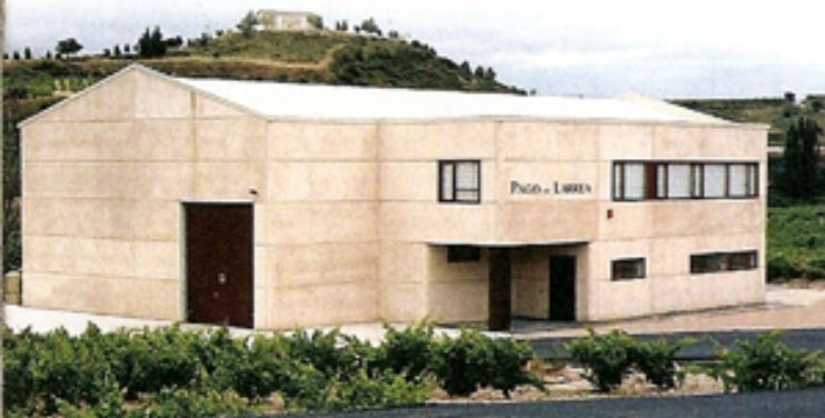
Instalaciones de Bodega Pago de Larrea.
